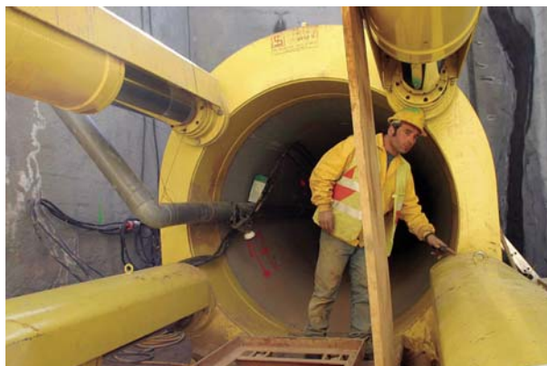
Un operari surt de l'interior del col·lector de Ronda.
