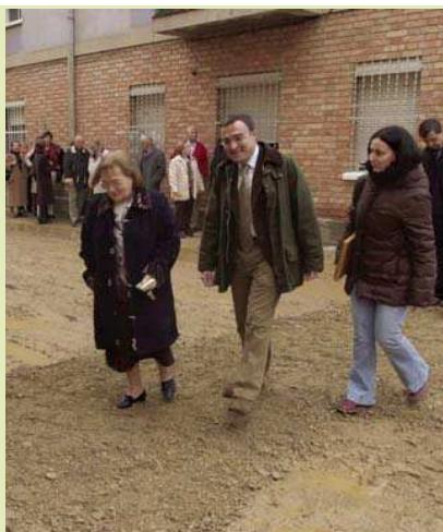
Visita d'obres a la zona interior dels blocs.
