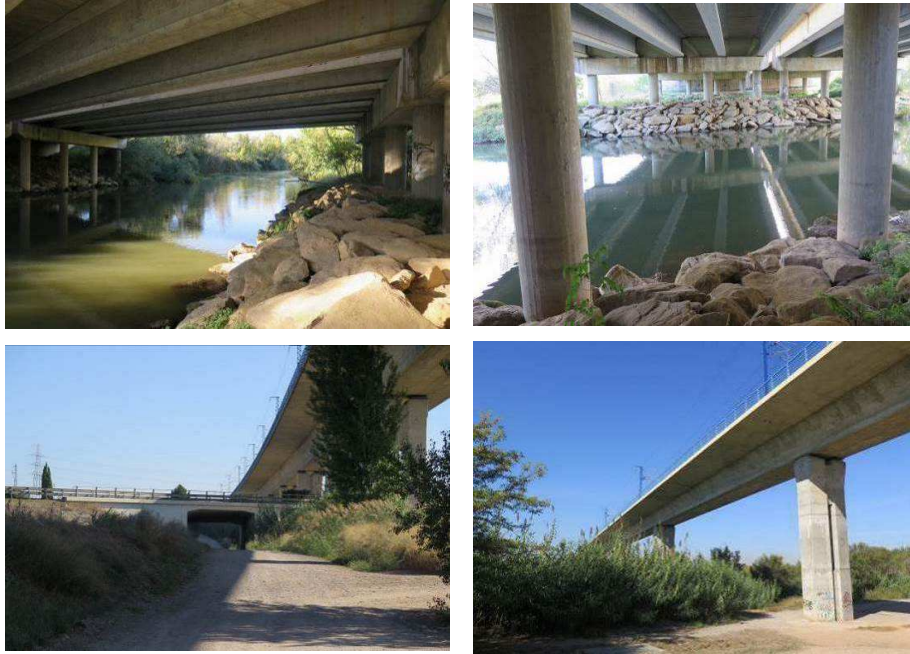
Figura 1.65. Imatges del viaducte de l'A-2 i del viaducte del tren d'alta velocitat.
