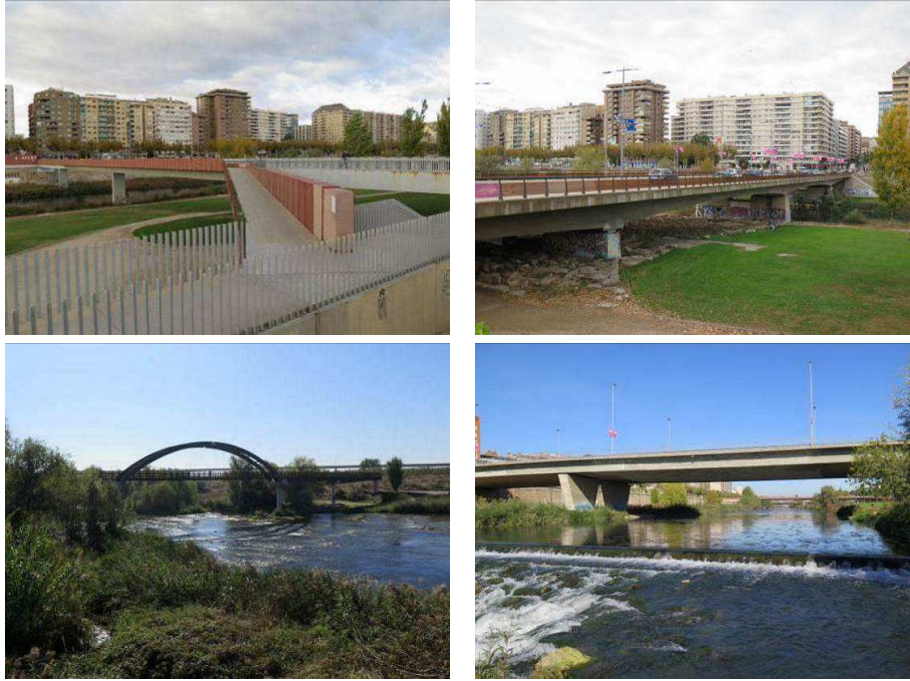
Figura 1.18. Imatges representatives de les diferents passarel·les (esquerra) i ponts (dreta) citats al text. Les passarel·les que es mostren a la columna esquerra, seguint el sentit nord-sud són les següents: Mitjana, Camps Elisis, Liceu Escolar, Maristes i de Rufeà. Pel que fa als ponts: Pardinyes, Príncep de Viana, Vell, de la Universitat, Nou o dels Instituts.
