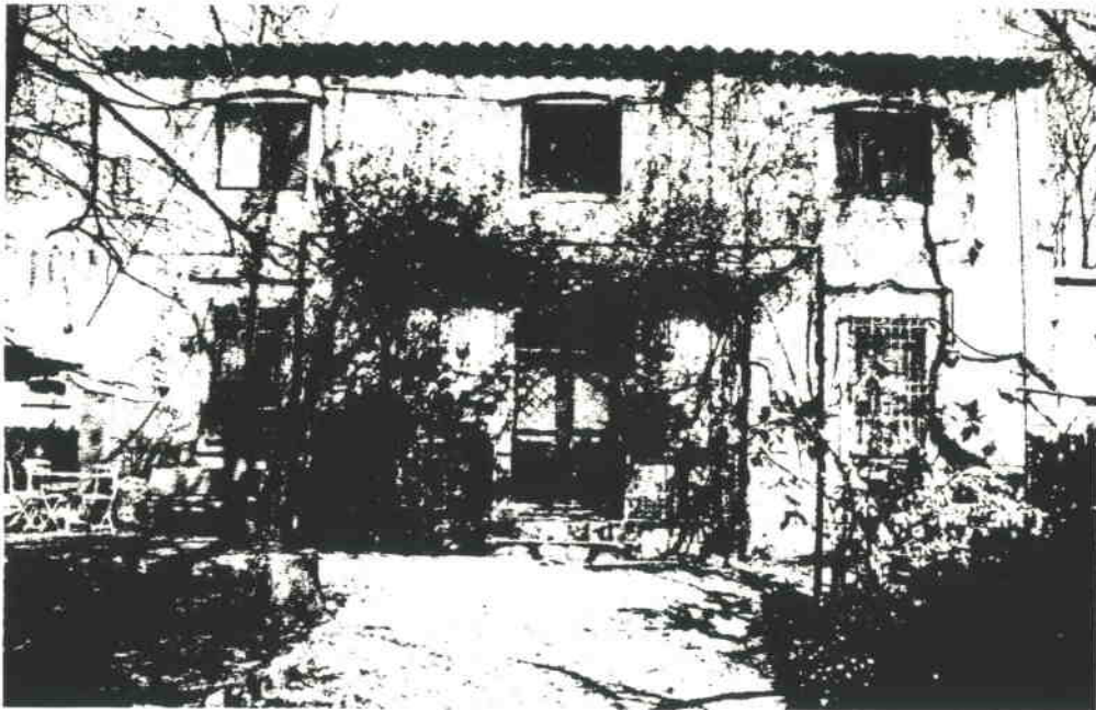
Façana al jardí de l'edifici principal.
