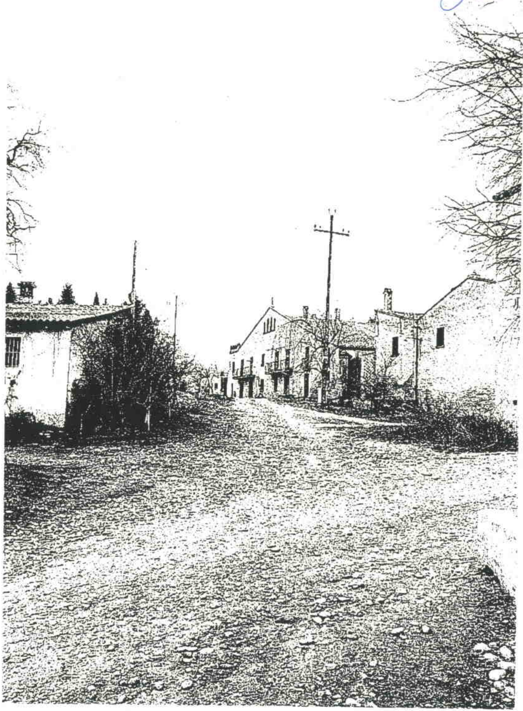
Aspecte general de l'accés a l'element.
