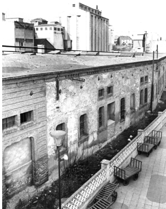
Façana des de les instal·lacions ferroviàries.
