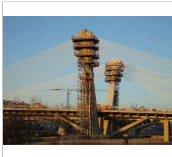
Vista de la construcció
