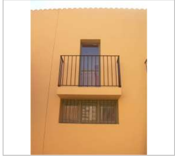
Detall de façana
