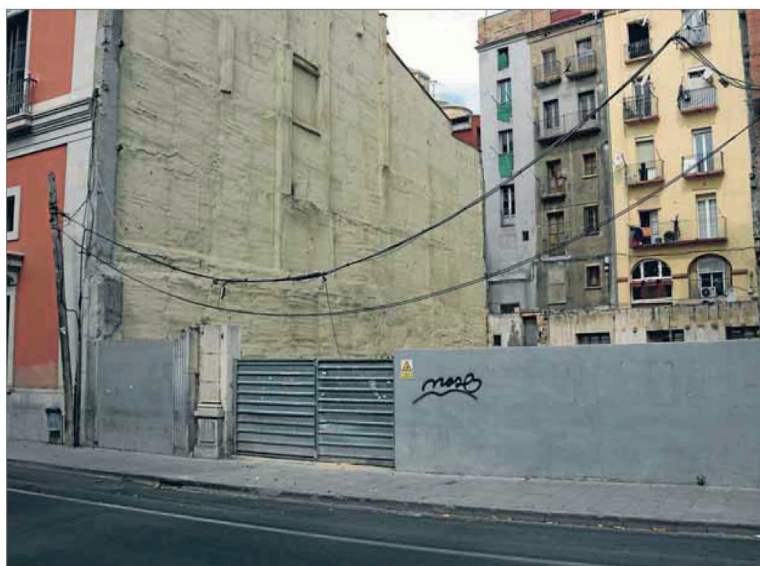
Solar on es construirà el nou edifici ■ ACN
